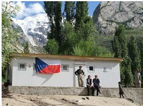
Další problém byla okna vyrobená v ČR. Jsou plněna plynem při tlakových podmínkách v poměrech v ČR. Tady, o 3000 m výš je tlak tak velký, že okna samovolně explodují. Konstrukce oken je taková, že je nelze rozebrat a skla vyměnit. Rámy oken jsou svařené. Na rozbitá skla jsem byl nucen silikonem nalepit skla nová.
